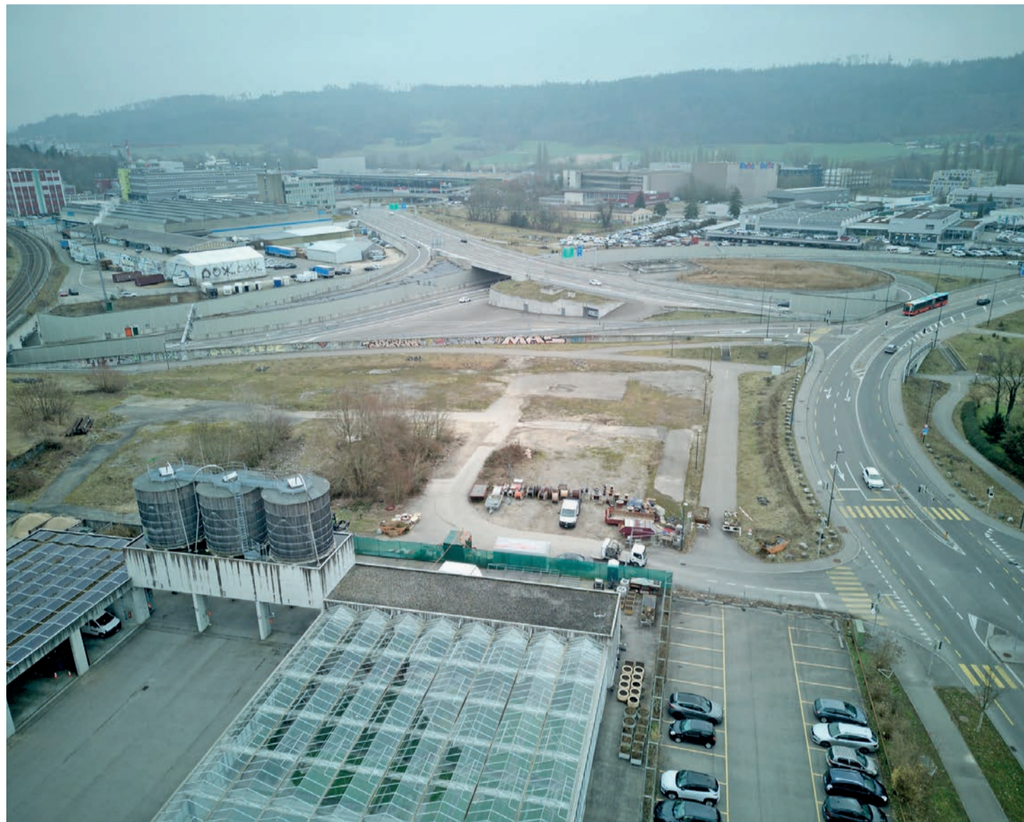
Direkt neben dem Werkhof soll der Recyclinghof gebaut werden.
