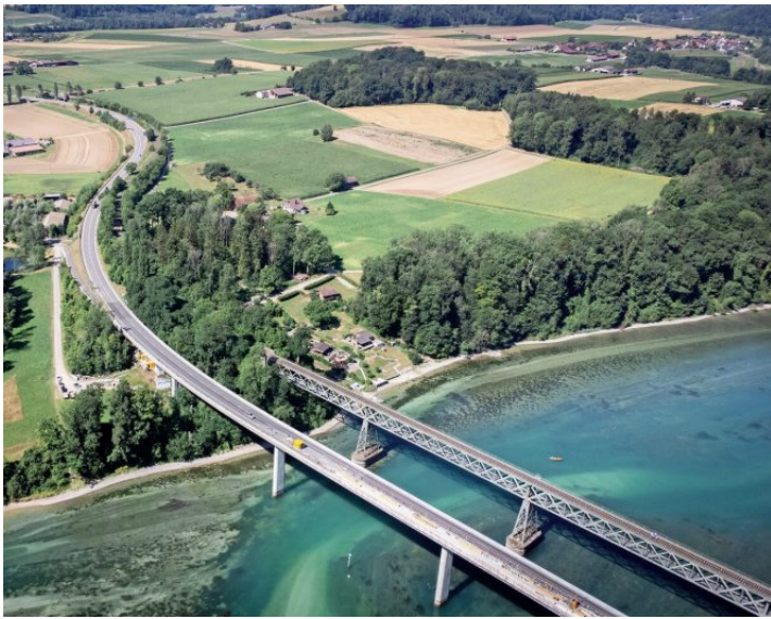
Unter der Hemishofer Brücke macht der Schiffsgraben einen Bogen: Hier haben sich tote Muscheln abgelagert und blockieren den Schiffsverkehr.
