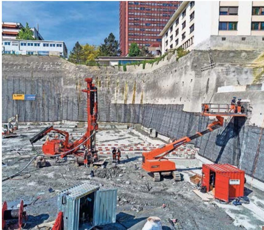
Aushubarbeiten für die neue Frauenklinik des Luzerner Kantonsspitals. Hier wurden Dutzende Erdsonden eingebaut. Bild: zvg/Reto Laederach/Luks
